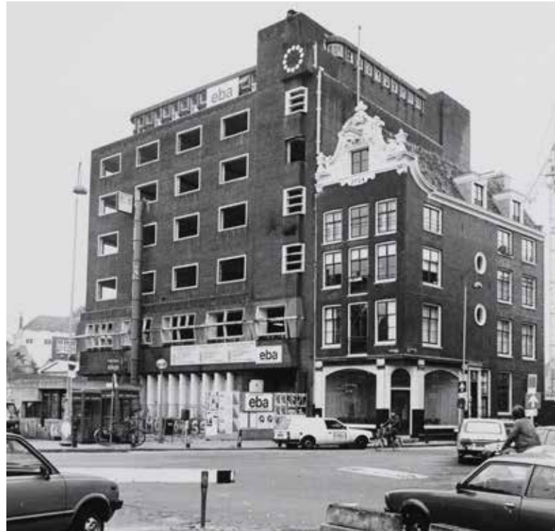
Nieuwmarkt 17-27, de verbouwing tot bejaardentehuis in het voormalige textielgebouw "Flesseman", oktober 1986. Foto: Stadsarchief Amsterdam / Ino Roël.
